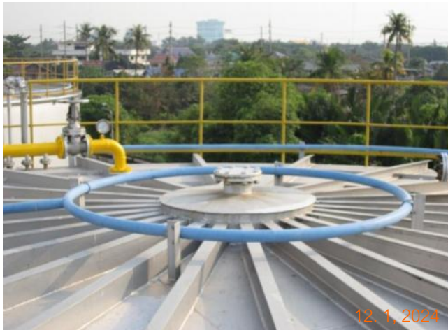
รูปที่ 2.2.1-6 ระบบท่อน้ำหล่อเย็นบนถังเก็บ
