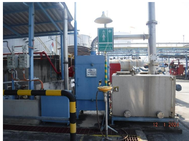
รูปที่ 2.2.4-3 ที่ล้างตาและอาบน้ำฉุกเฉิน
