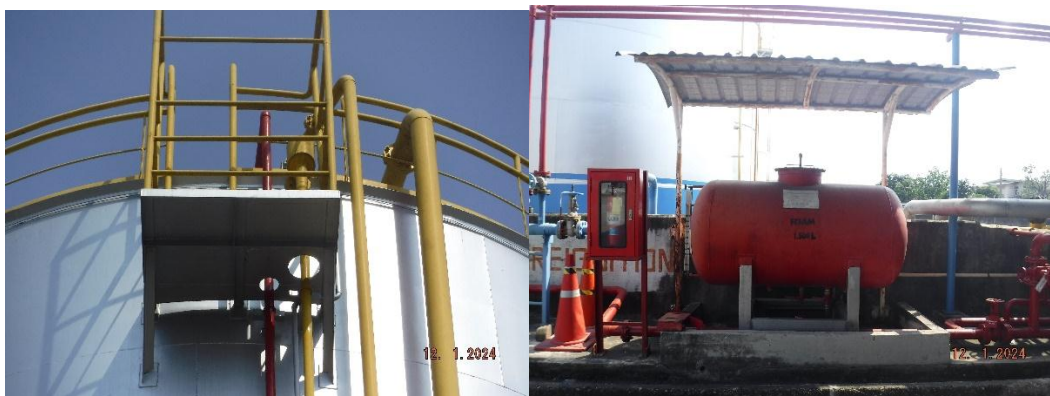
รูปที่ 2.2.1-4 Air Foam Chamber (หัวต่อท่อสีแดง)
