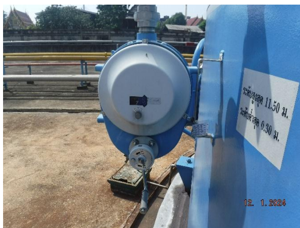
รูปที่ 2.2.1-2 Level Gauge
