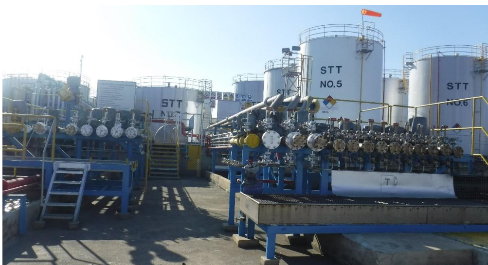
รูปที่ 1.4.5-1 ท่อขนาดเส้นผ่านศูนย์กลาง 6 นิ้ว สำหรับสูบเคมีภัณฑ์จากเรือ เพื่อส่งไปลงในถังเก็บเคมีภัณฑ์ โดยด้านล่างเป็นถังสำหรับรองรับสารเคมีที่อาจรั่วไหลจากข้อต่อของท่อถ่ายสารเคมี
