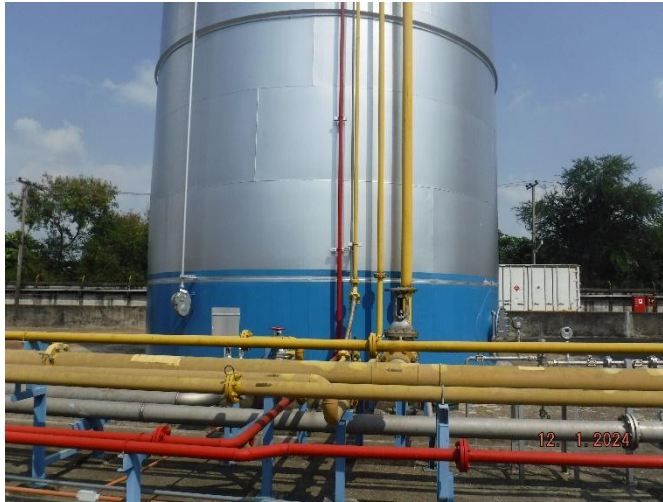
รูปที่ 2.2.1-5 Air Foam Chamber สีเหลือง, ระบบท่อดับเพลิงสีแดง
