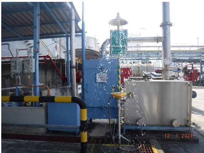
รูปที่ 2.2.4-3 ที่ล้างตาและอาบน้ำฉุกเฉิน
