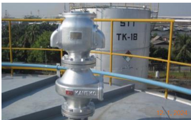
รูปที่ 2.2.1-1 Automatic Breather Valve
