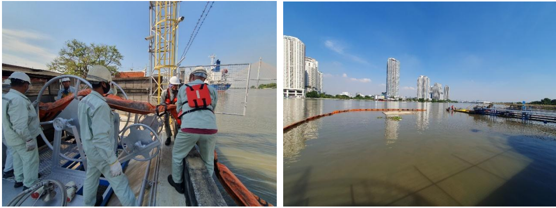
รูปที่ 2.2.2-8 การวาง Boom ทางทิศเหนือ (ซ้าย) และทิศใต้ (ขวา)
